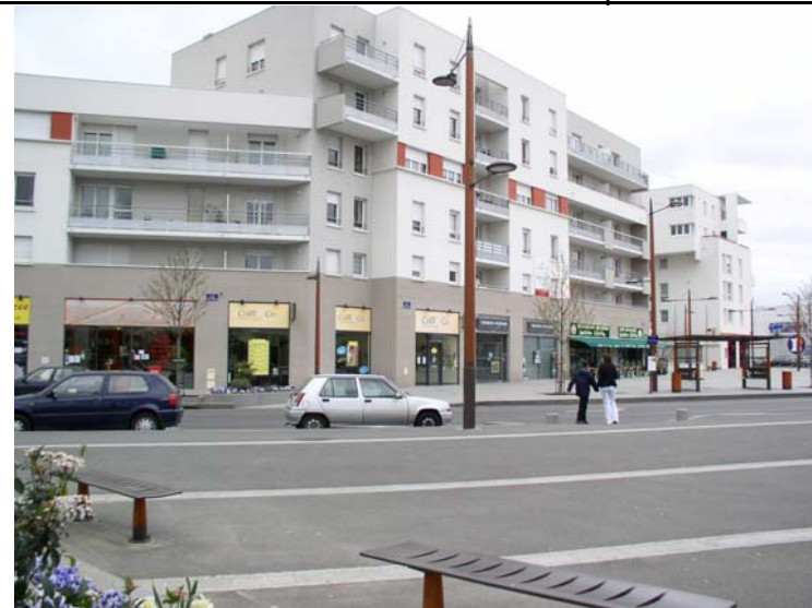
Les commerces en Rez de chaussée dans le quartier Fer à Cheval
