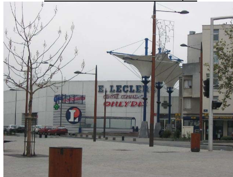
L'entrée du centre commercial Orlydis
