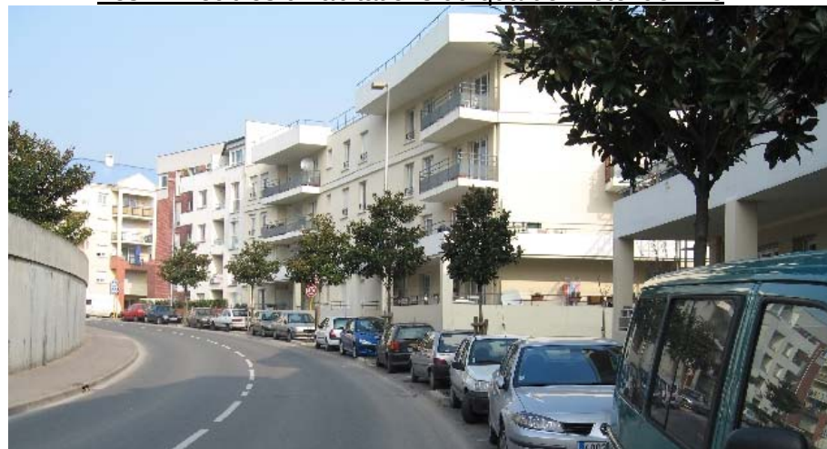
Les immeubles d'habitations du quartier hôtel de ville
