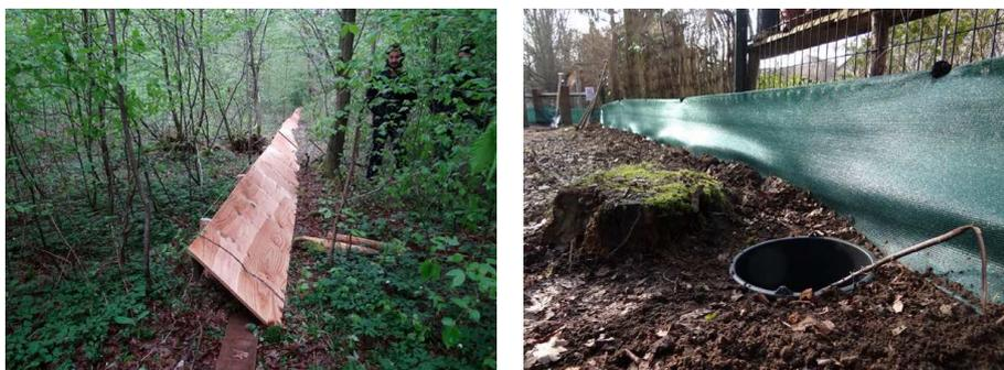
**Photo 5 : exemples de barrières mises en place dans le cadre d'actions de sauvegarde de populations d'amphibiens.**
