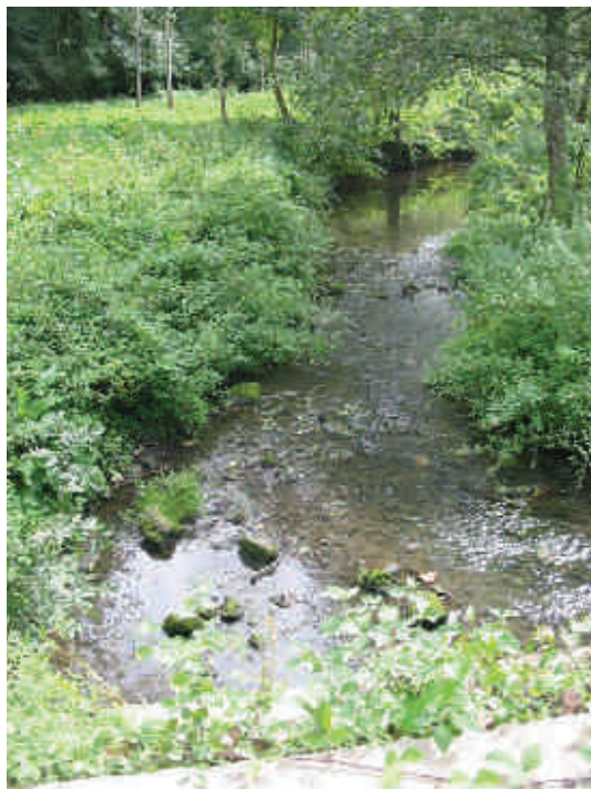
Vue du site vers l'aval du pont
