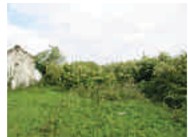
Vue aval du massif
