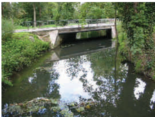
Vue juste à l'amont du seuil
