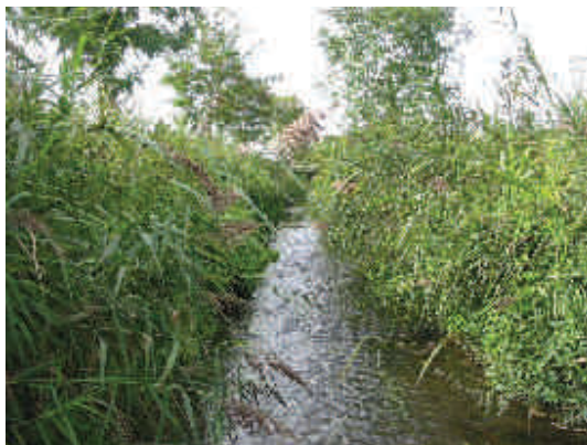
Vue de la partie médiane du site
