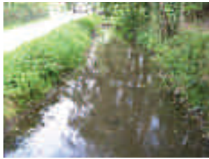
Vue amont (après l'abaissement de la vanne)
