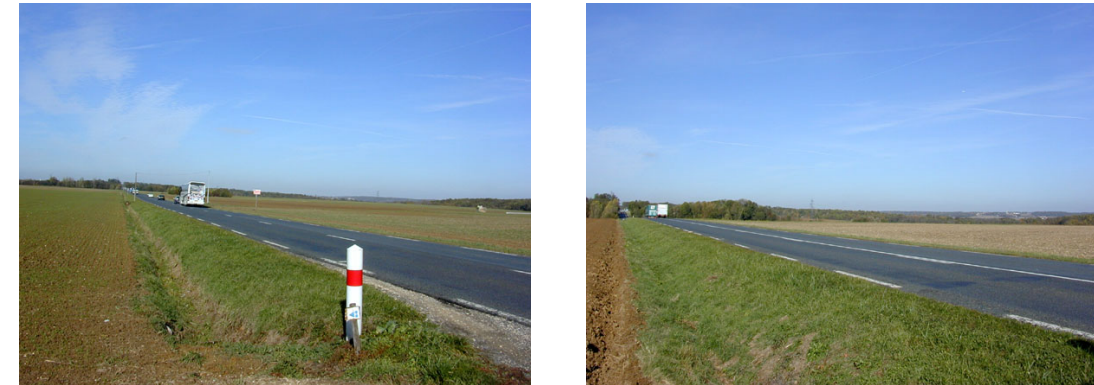
Fossés existants le long de la RN 36
