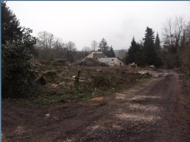
A gauche, construction isolée à Mouroux.
