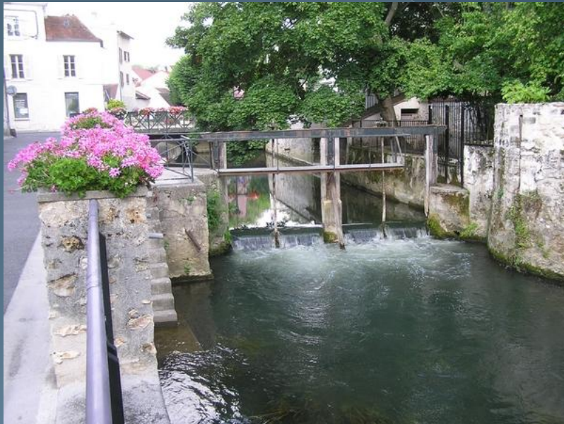
Un vannage sur un brasnet à Crécy-la-Chapelle
